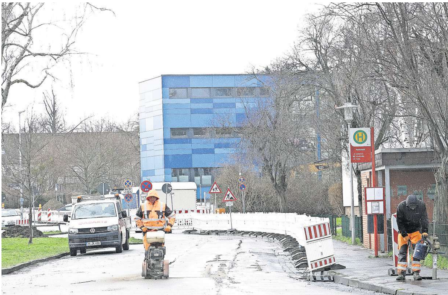
Bauarbeiten vor der gesperrten Bushaltestelle Nordstadt.
