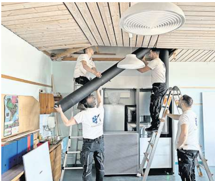
Ein Anblick, der dieses Jahr in mehreren Schulen des Landkreises zu sehen sein soll: Einbau eines Raumlüfters in der Hildesheimer Waldorfschule.
