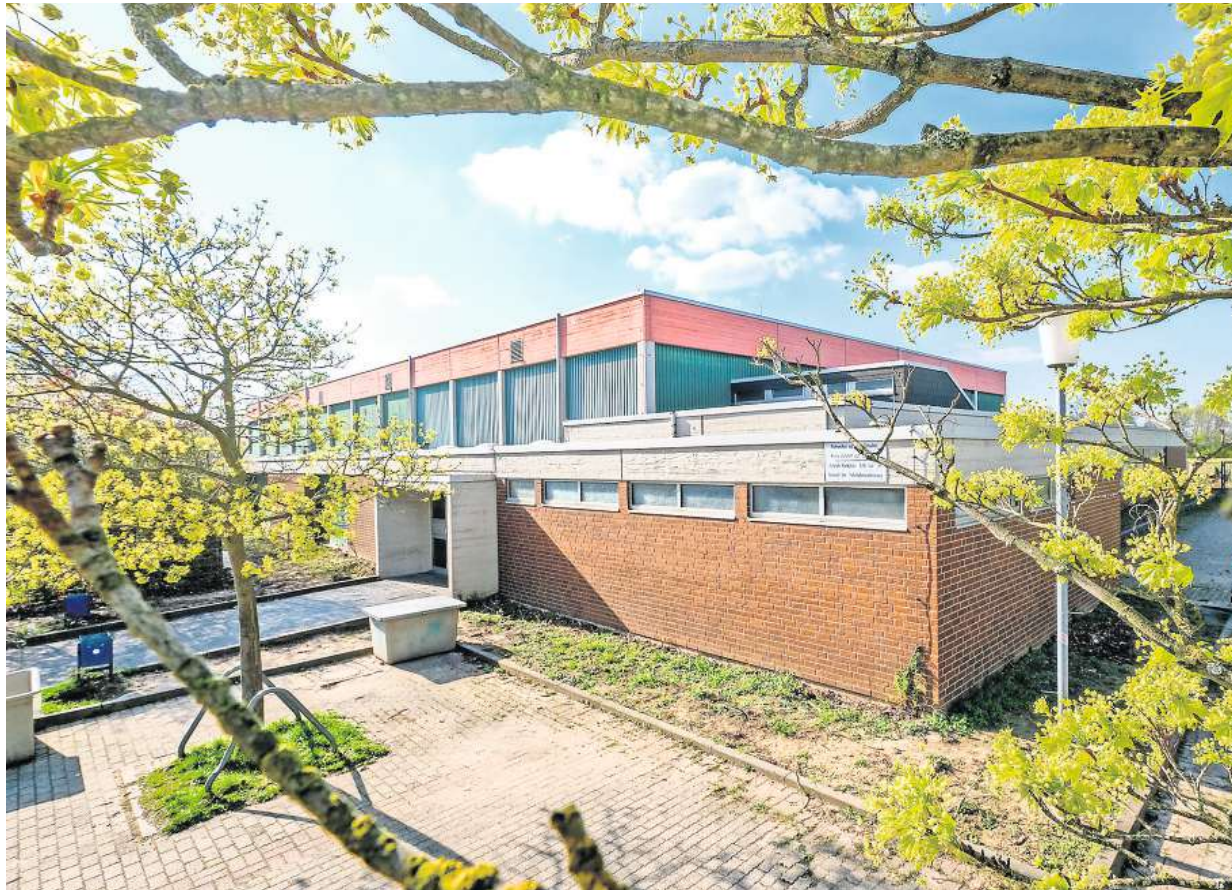
Die Sporthalle der Robert-Bosch-Gesamtschule soll umfassend saniert werden.
