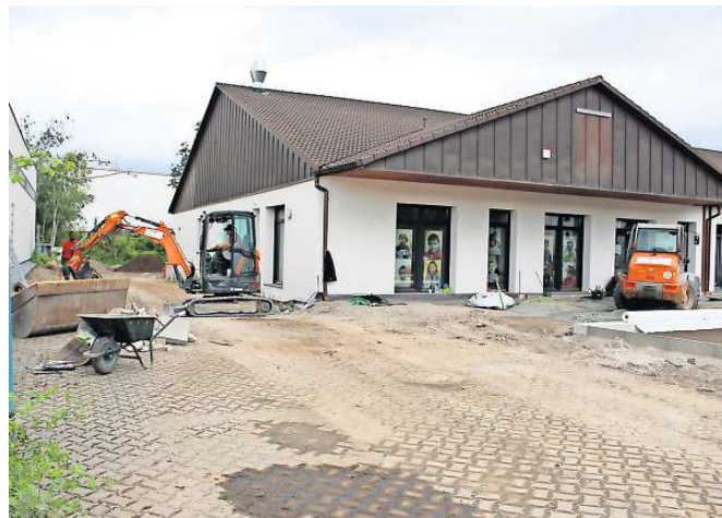
Das Außengelände nimmt allmählich Formen an: Am Go20-Zentrum laufen jetzt die Sanierungsarbeiten.
