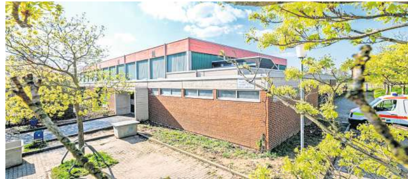
Allein die Sporthalle der Robert-Bosch-Gesamtschule soll für 2,9 Millionen Euro saniert werden. Allerdings haben die Arbeiten noch nicht begonnen.
