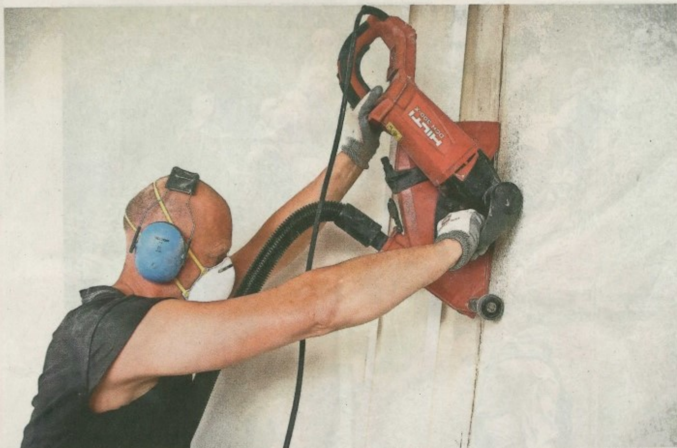
Knochenarbeit: Für eine neue Brandschutztür in einem Verbindungsgang muss Peter Frahm die Wand aufzrösen.
