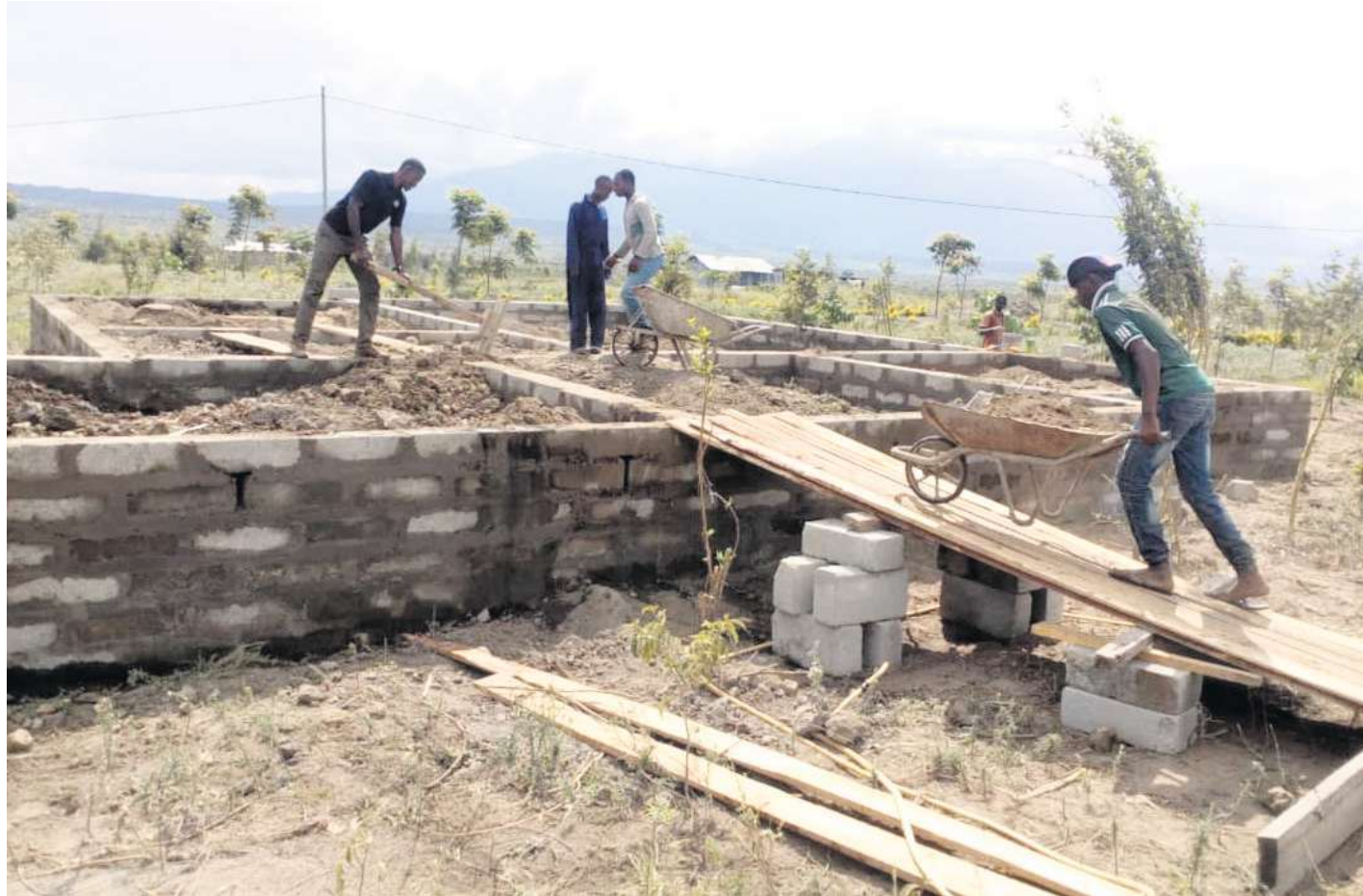
Bauarbeiter haben mit den Arbeiten am neuen Haus begonnen. Hier sollen nach der Fertigstellung auch Gäste untergebracht werden.
